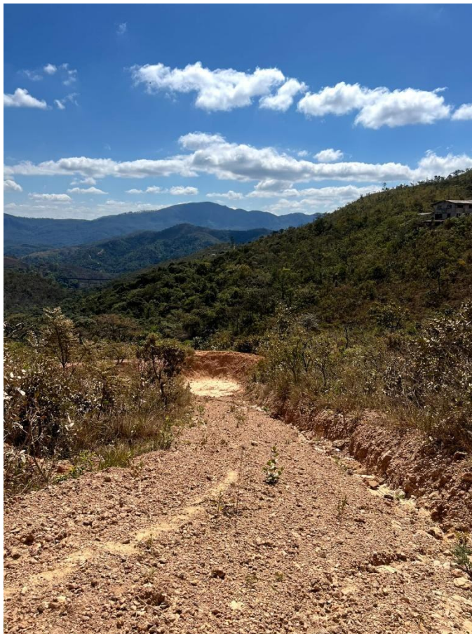
Figura 13: Barraginha construída para conter sedimentos a montante do córrego São José. Autoria: Paula Grandi Data: 01/08/2024.
